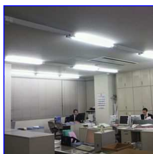
電灯の間引きと不在箇所の消灯
